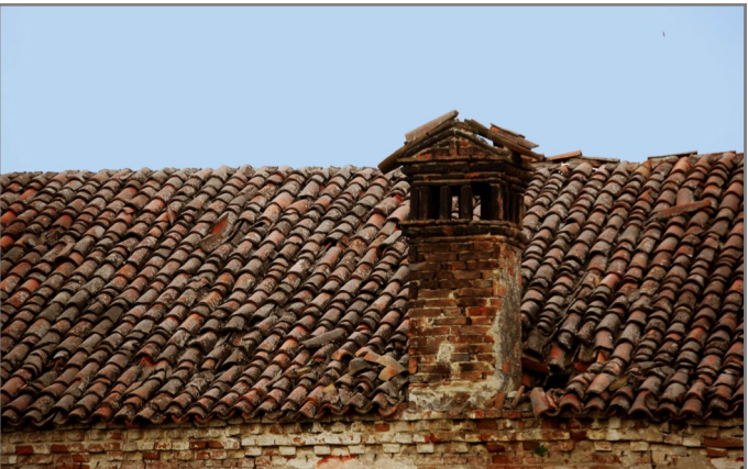
Torretta del camino
